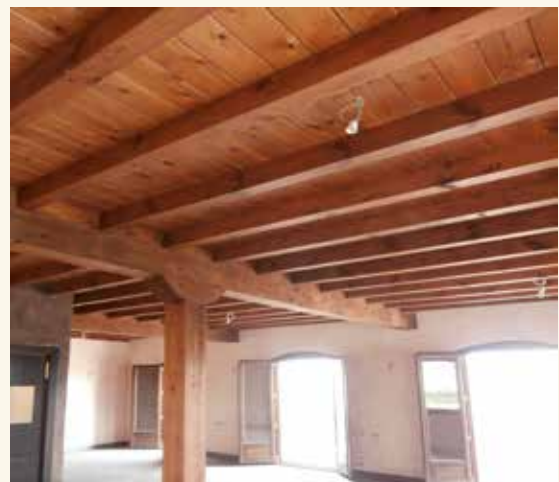
Vigas y friso de madera maciza.
